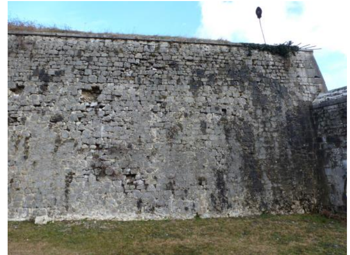
Face droite du bastion des Morges: maçonnerie instable et lessivée. Parements imbibés
