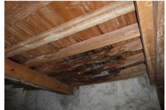
Dégradation du plancher haut de la poudrière suite à des infiltrations en couverture.
