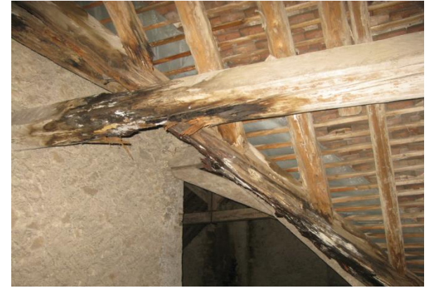
Forte dégradation de la charpente par des infiltrations en couverture.
