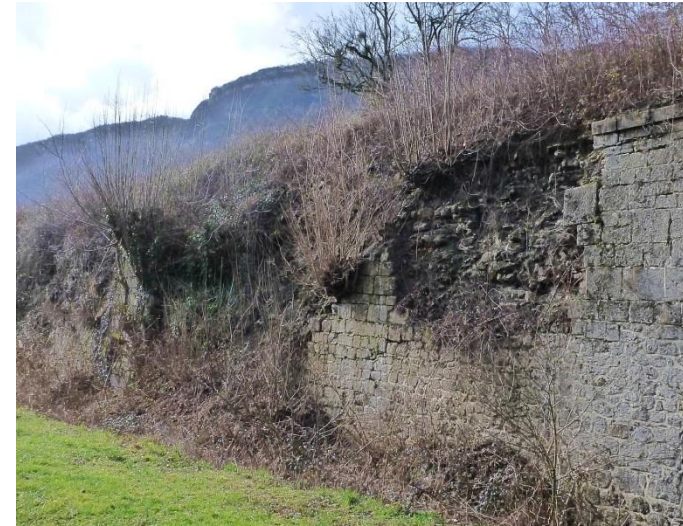
Contrescarpe Ouest du front de Barraux : parements éboulés et envahis par la végétation. Maçonnerie contiguë instable.
