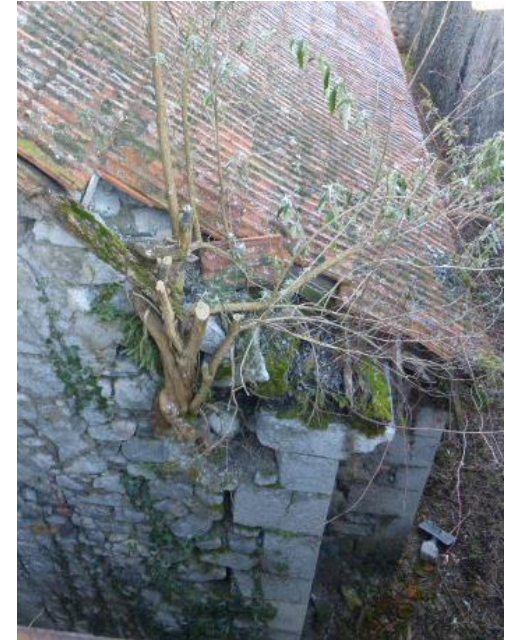
Forte dégradation de la maçonnerie extérieure de la Grande Poudrière.
